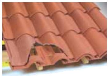
Pose du closoir d'égout, fixé par la tuile du 1 er rang, par crochet V2 Réf. CRV02. (Le linteau ou le bandeau d'égout n'est plus relevé pour éviter le basculement du 1 er rang de tuiles).
