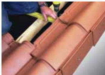
Fixation des tuiles en rive latérale droite par crochet "V2" Réf. CRV02.
