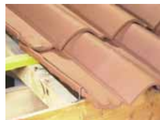
Fixation des tuiles du 1 er rang d'égout par crochet "V2" Réf. CRV02.
